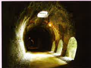
排煙口のある6号トンネル内部
