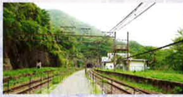
熊ノ平から10号トンネル方面
