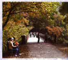
6号トンネル側からの橋梁
